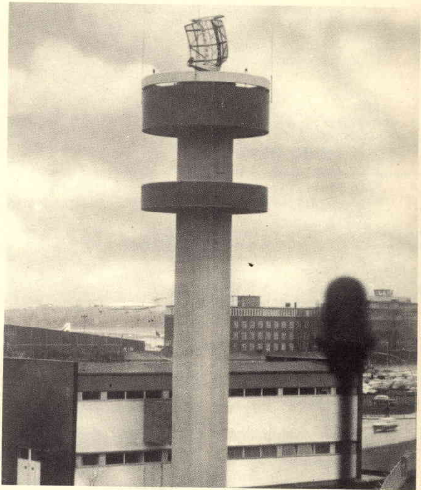
Fig. 8 - Stazione di sorveglianza dell'aeroporto di Amburgo con impianto radiogoniometrico e radar.
